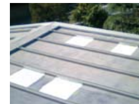
遮熱塗料塗布例：白色部分
